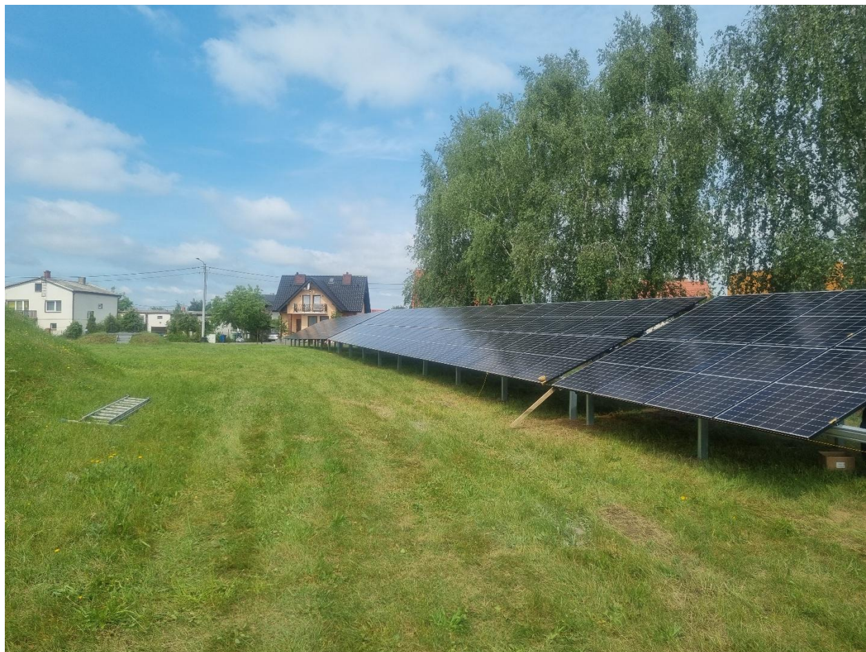
Opis zdjęcia: realizacja instalacji PV przy stacji uzdatniania wody, źródło: Gmina Wilczyn
